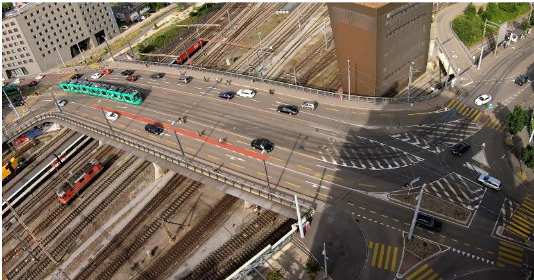
Abbildung 3: Überblick vom Dach des Coop-Hochhauses
